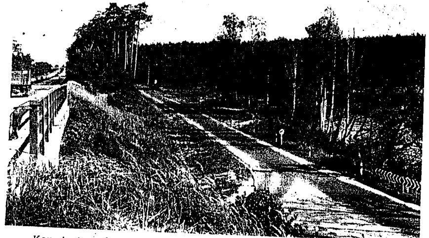
„Kometentunnel“ – die 1968 gebaute Autobahnauffahrt bei Neuhaus
